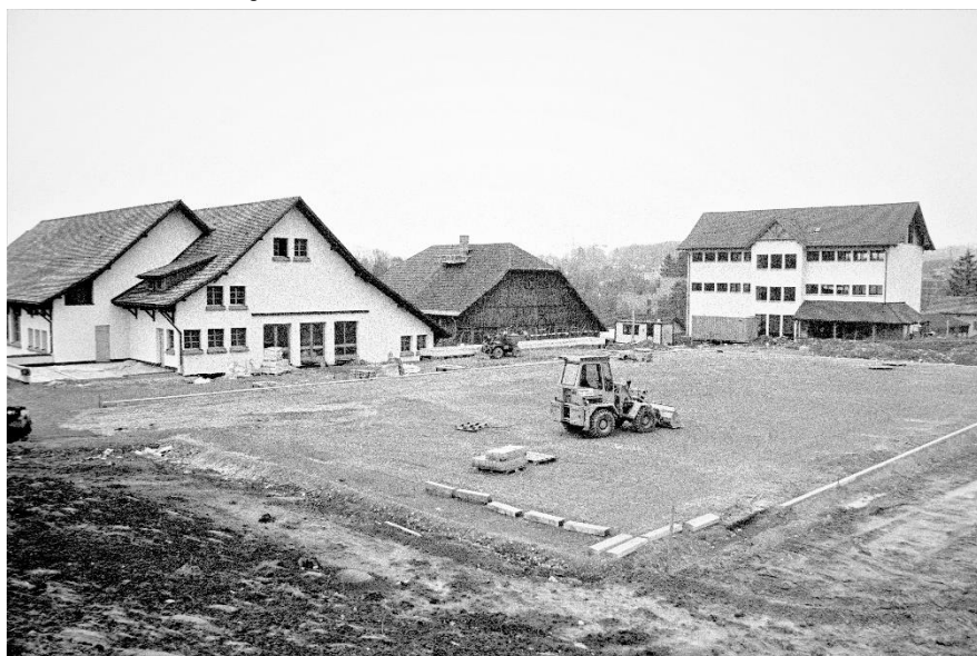
Schwerzi im Bau, 1984
